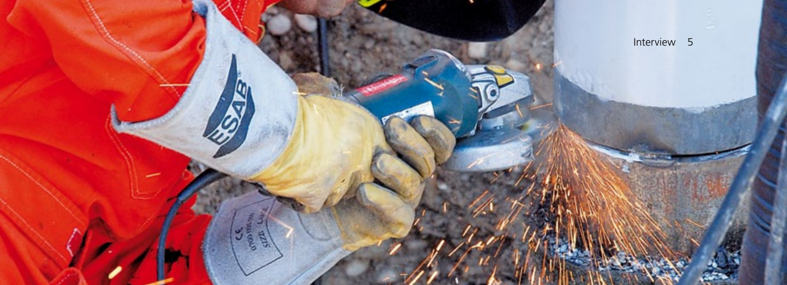
Schweisnahtvorbereitung / Schleifarbeiten.
