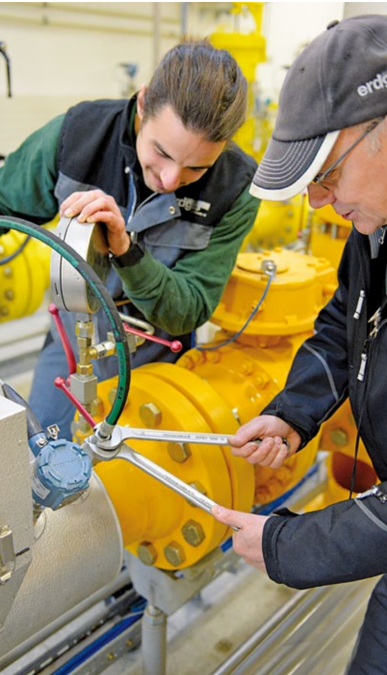
Anschliessen der Prüfschläuche.
