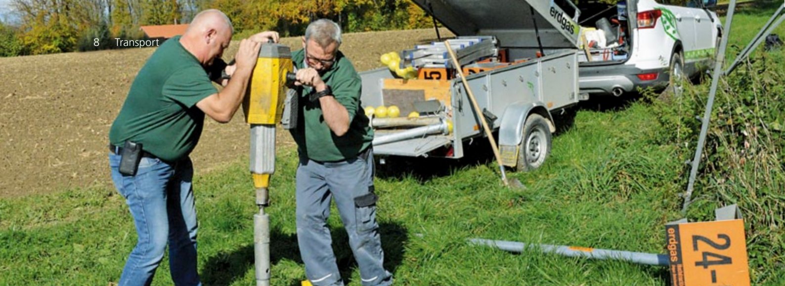
Vorbereitungsarbeiten für die Verankerung einer Flugmarkierung, im Volksmund «Vogelhäuschen» genannt.
