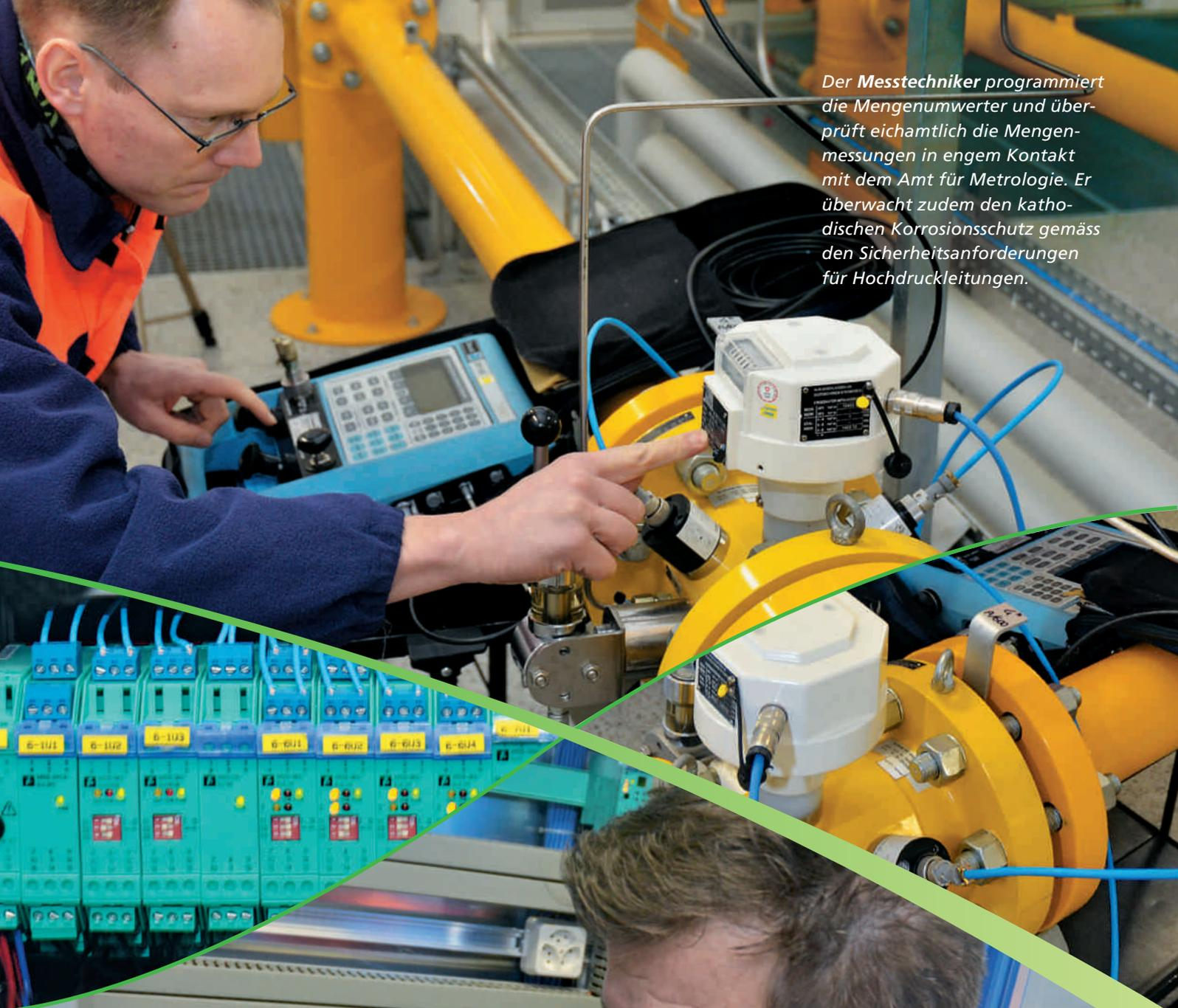
Der **Messtechniker** programmiert die Mengenumwerter und überprüft eichamtlich die Mengemessungen in engem Kontakt mit dem Amt für Metrologie. Er überwacht zudem den kathodischen Korrosionsschutz gemäss den Sicherheitsanforderungen für Hochdruckleitungen.
