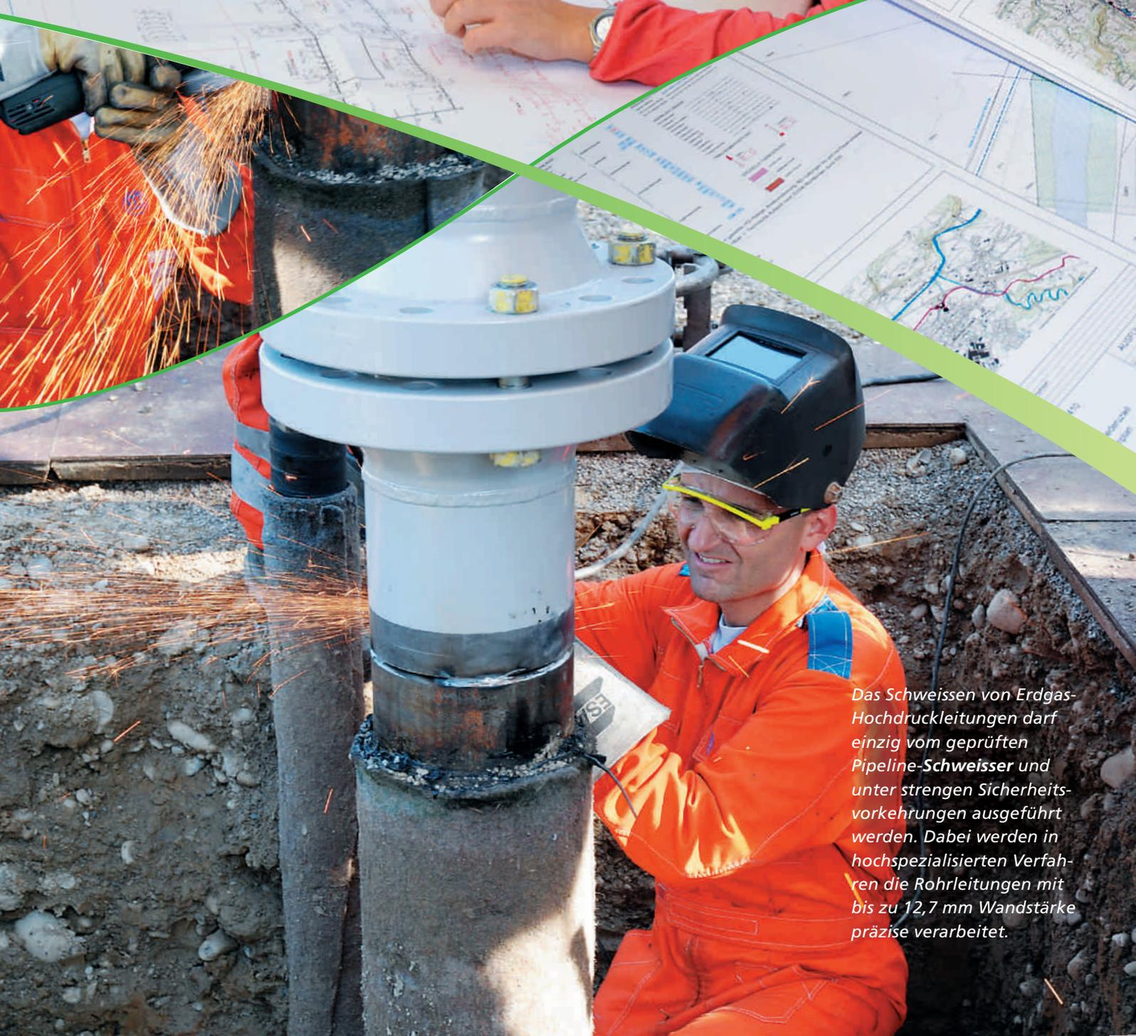
Das Schweißen von Erdgas-Hochdruckleitungen darf einzig vom geprüften Pipeline-Schweisser und unter strengen Sicherheitsvorkehrungen ausgeführt werden. Dabei werden in hochspezialisierten Verfahren die Rohrleitungen mit bis zu 12,7 mm Wandstärke präzise verarbeitet.
