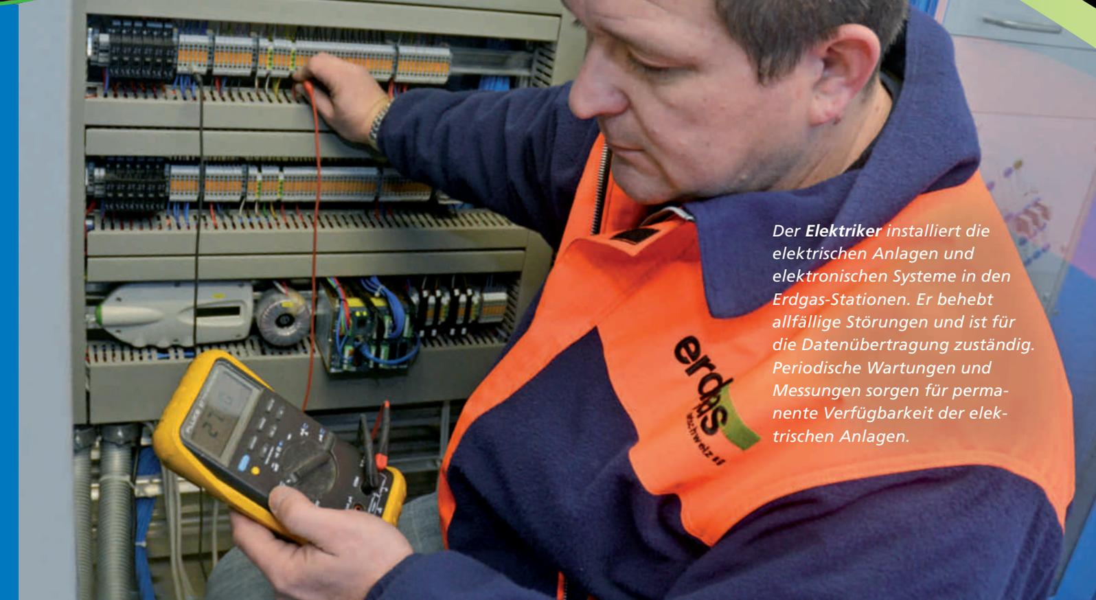
Der **Elektriker** installiert die elektrischen Anlagen und elektronischen Systeme in den Erdgas-Stationen. Er behebt allfällige Störungen und ist für die Datenübertragung zuständig. Periodische Wartungen und Messungen sorgen für permanente Verfügbarkeit der elektrischen Anlagen.
