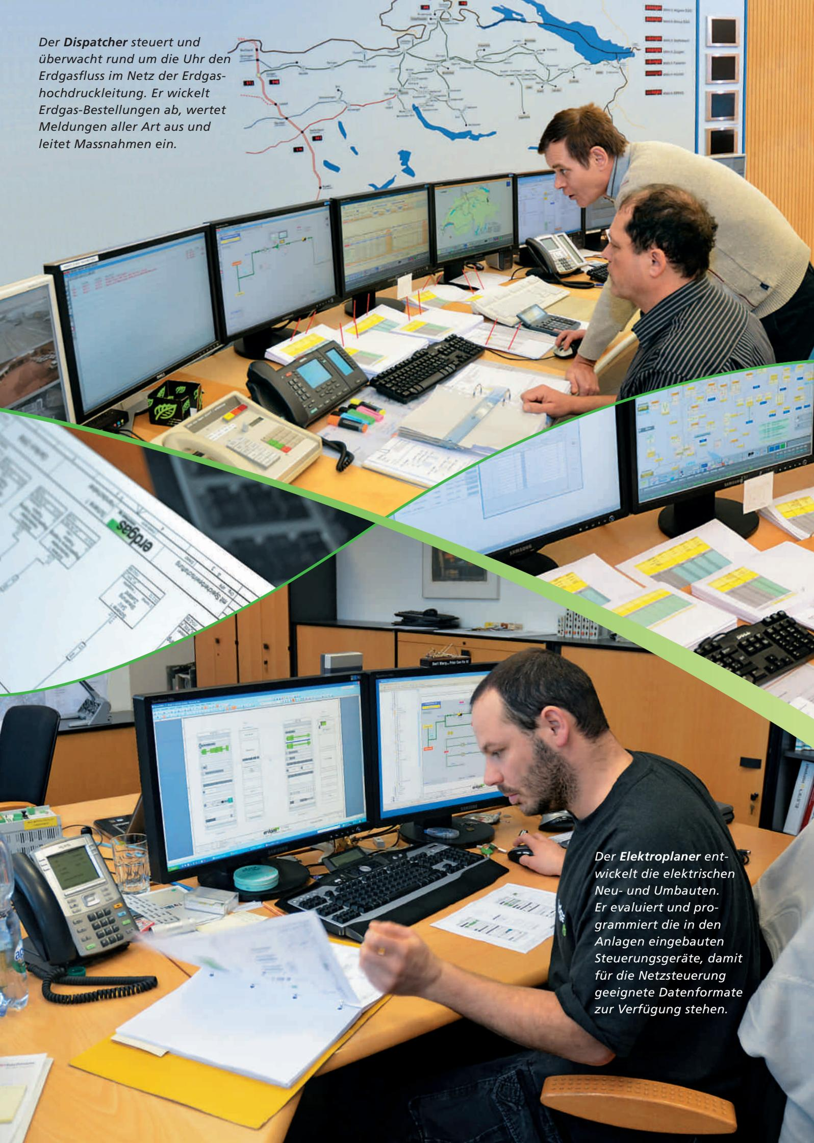
Der **Elektroplaner** entwickelt die elektrischen Neu- und Umbauten. Er evaluiert und programmiert die in den Anlagen eingebauten Steuerungsgeräte, damit für die Netzsteuerung geeignete Datenformate zur Verfügung stehen.
